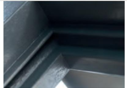
Der Clou: unsere Wirbelkammer. Mit 9 mm Tiefe und 15 mm Breite funktioniert sie wie eine Dachrinne im Blendrahmenfalz. Bei dieser Größe läuft Wasser selbst bei Schlagregen ungehindert nach unten ab. Die Tür ist absolut dicht.
