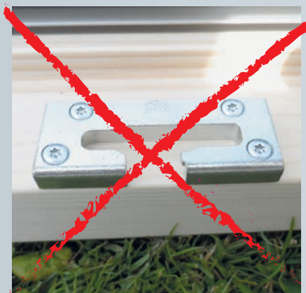
Aufgeschraubtes Schließblech
