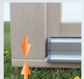
Eine schmale Bewitterungsfuge von 1,5 mm sorgt für besten Witterschutz und längere Haltbarkeit
