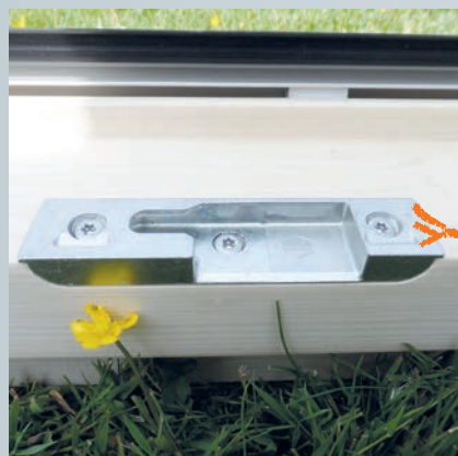
Eingefrästes Schließblech
